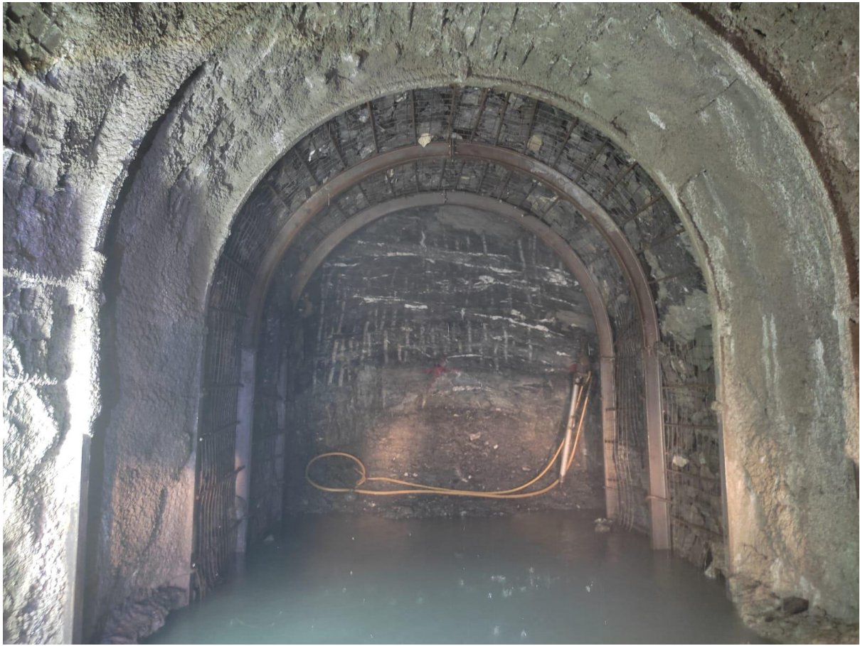
Figure 19: Adit 3 HRT DS
