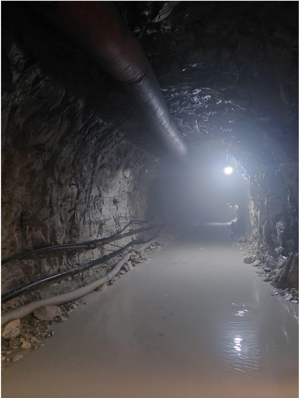
Figure 11: Adit 2 HRT DS
